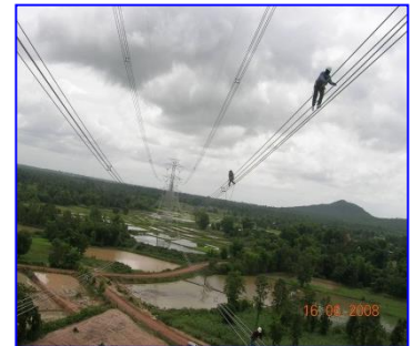
ขั้นตอนที่ 6 งานขึงสายไฟฟ้า และตรวจสอบสายส่งไฟฟ้าก่อน
