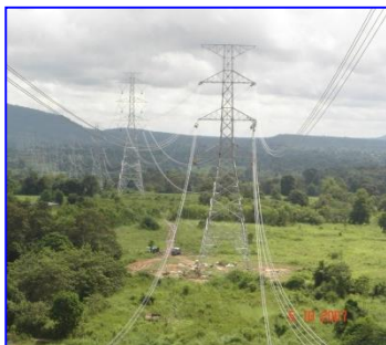
ขั้นตอนที่ 6 งานขึงสายไฟฟ้า และตรวจสอบสายส่งไฟฟ้าก่อน
