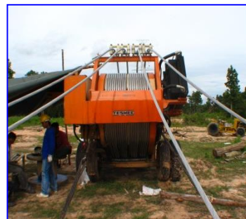
ขั้นตอนที่ 6 งานขึงสายไฟฟ้า และตรวจสอบสายส่งไฟฟ้าก่อน
