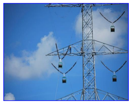
ขั้นตอนที่ 5 งานติดตั้งเสาโครงเหล็กและแขวนลูกถ้วยเตรียมงานขึง
