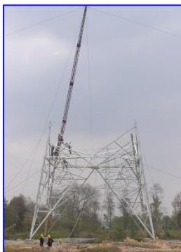
ขั้นตอนที่ 5 งานติดตั้งเสาโครงเหล็กและแขวนลูกถ้วยเตรียมงานขึง
